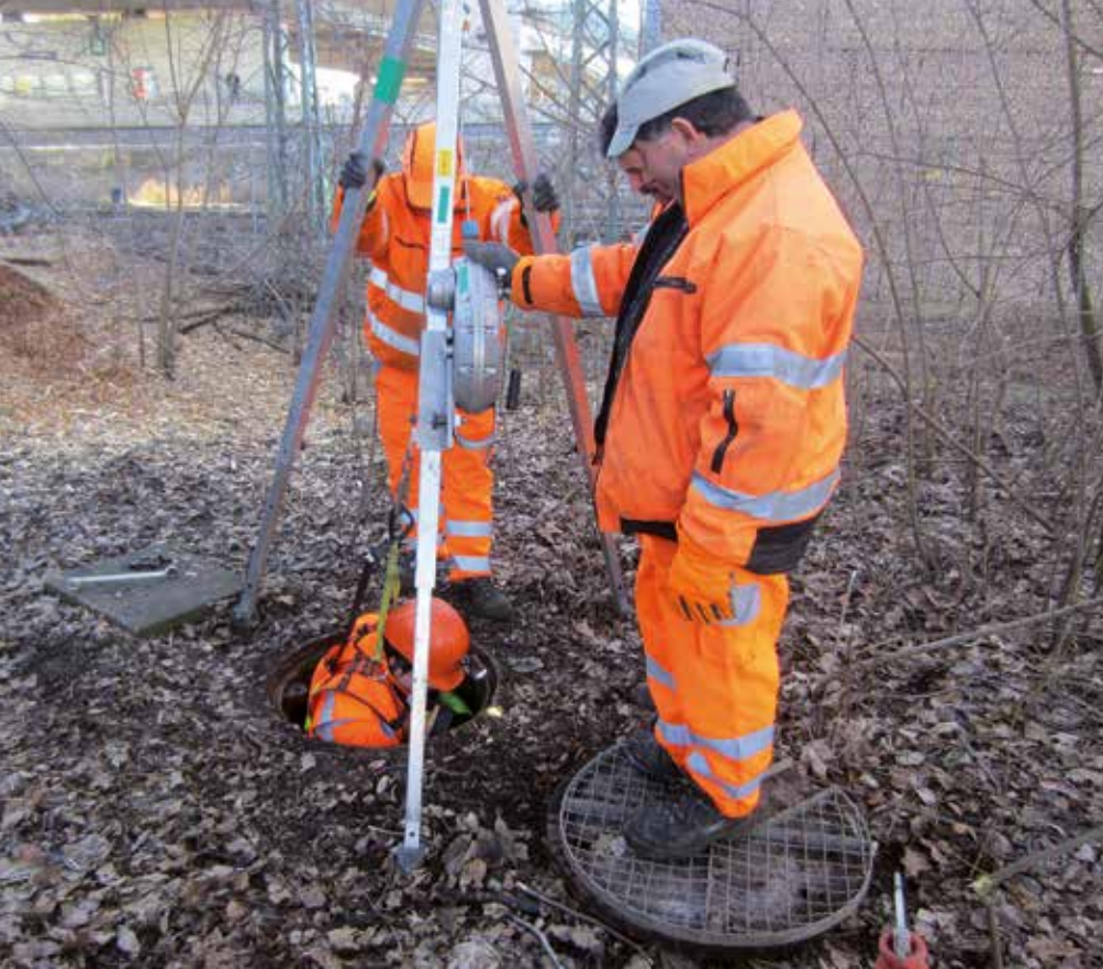
[ Sicherungsmaßnahmen beim Einstiegsschacht
