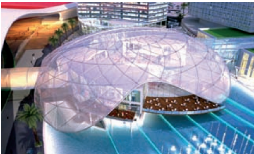
Der Pavillon besticht durch seine Transparenz und Leichtigkeit. Die massive Stahlkonstruktion, die die ETFE-Membran trägt, wirkt beinahe zerbrechlich.
