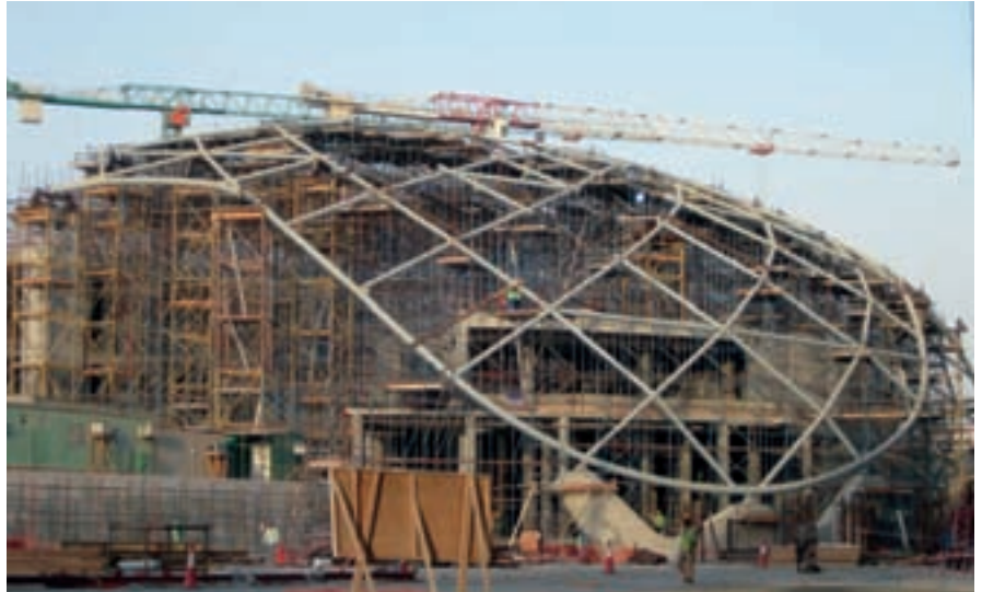
Die tragende Stahlkonstruktion hat einen Durchmesser von etwa 105 Metern. Das Dachtragwerk wurde anschließend an der Oberseite durch 400 Membranfelder mit einer Gesamtfläche von etwa 13.000 Quadratmetern verkleidet.
