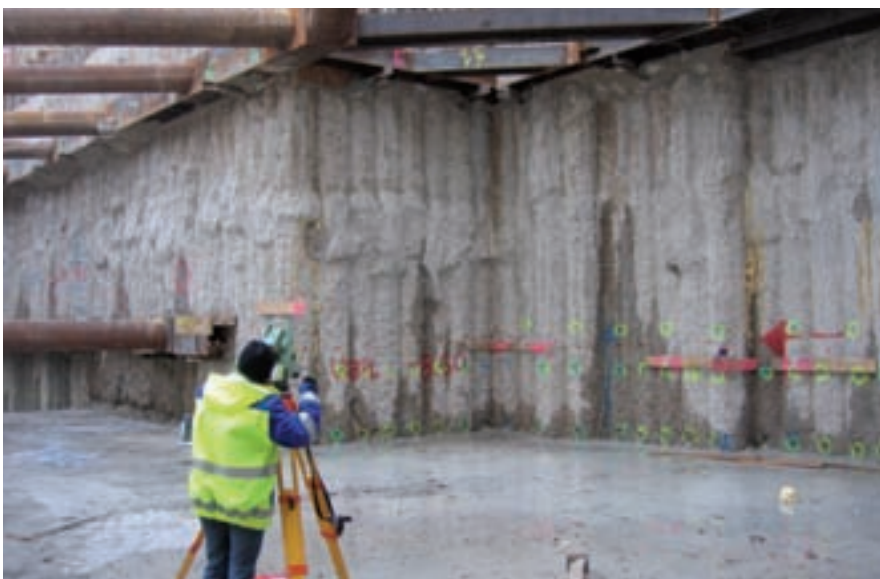
Es muss nicht immer eine Fassade sein – auch eine Bohrpfehlwand kann hinsichtlich ihrer Genauigkeit untersucht werden.
