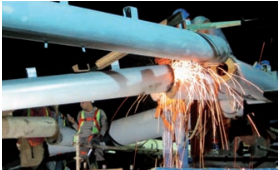
Nächtliche Schweißarbeiten an den Stahlträgern
