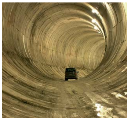
Im Größenvergleich (zu dem im Photo abgebildeten Bus) werden die enormen Dimensionen des Tunnels (12m Durchmesser) deutlich.
